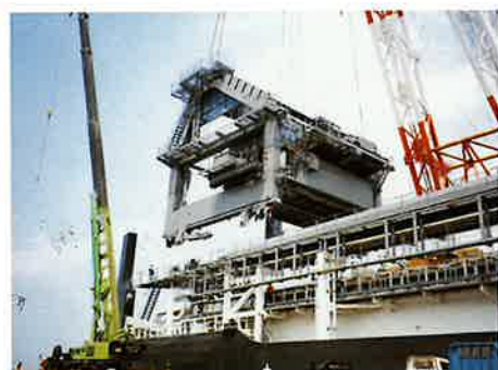
国内での艀装工事
