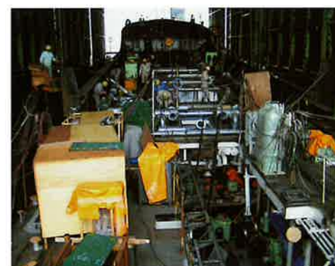
ドーム内先行艤装工事
