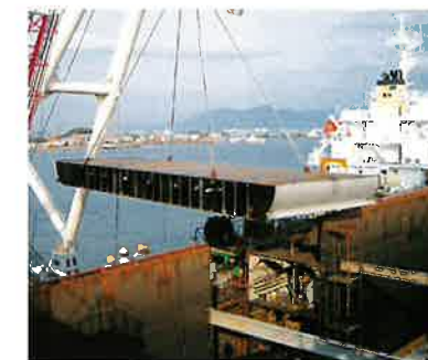
4000DWT 砂利運搬船船体延長
